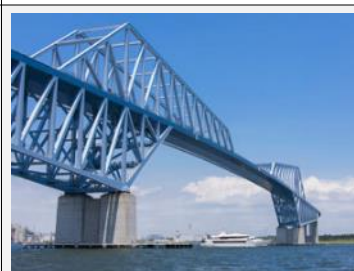
8 東京ゲートブリッジ 全長2618mのトラス構造、 海面までの高さ54.6m
