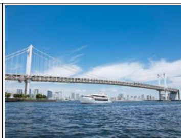
2 レインボーブリッジ つり橋の長さ918m、主塔高 127m、海面からの高さ52.4m
